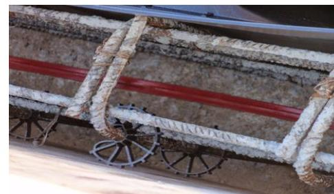
**DISTANCIA RECOMENDADA DE 50 a 90 cm**, DEPENDE DEL TIPO DE ARMADURA, BARRAS CORRUGADAS Ó MALLA ELECTROSOLDADA Y Ø DE LAS MISMAS.
